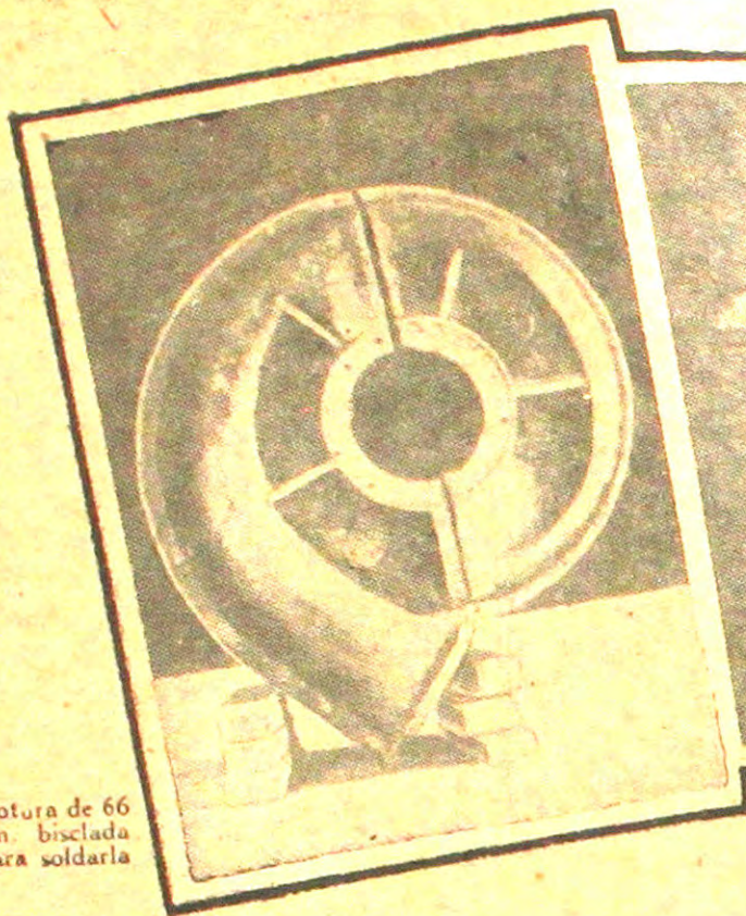
La soldadura después de terminada.
